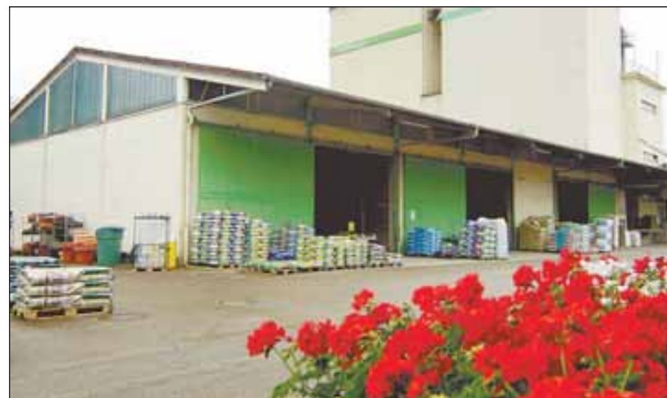
Der jetzige Raiffeisenmarkt soll nach dem Neubau als Lager dienen. Foto: Guzy
